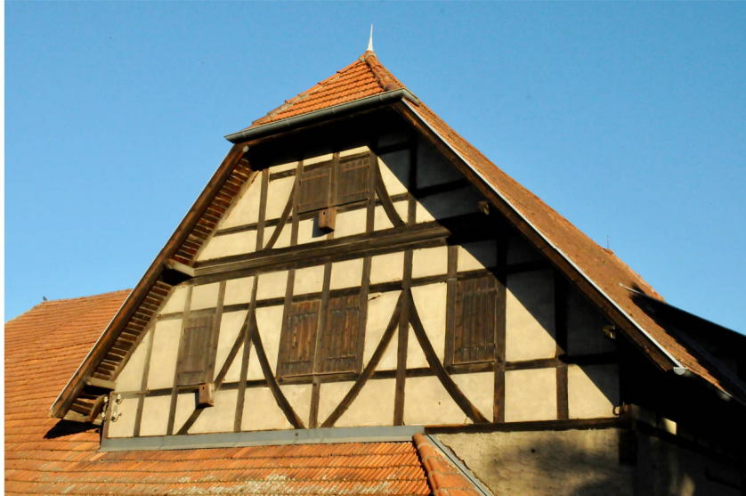
Südost-Giebel mit rund gesägten Fußstreben (Foto: R. Wahl)
